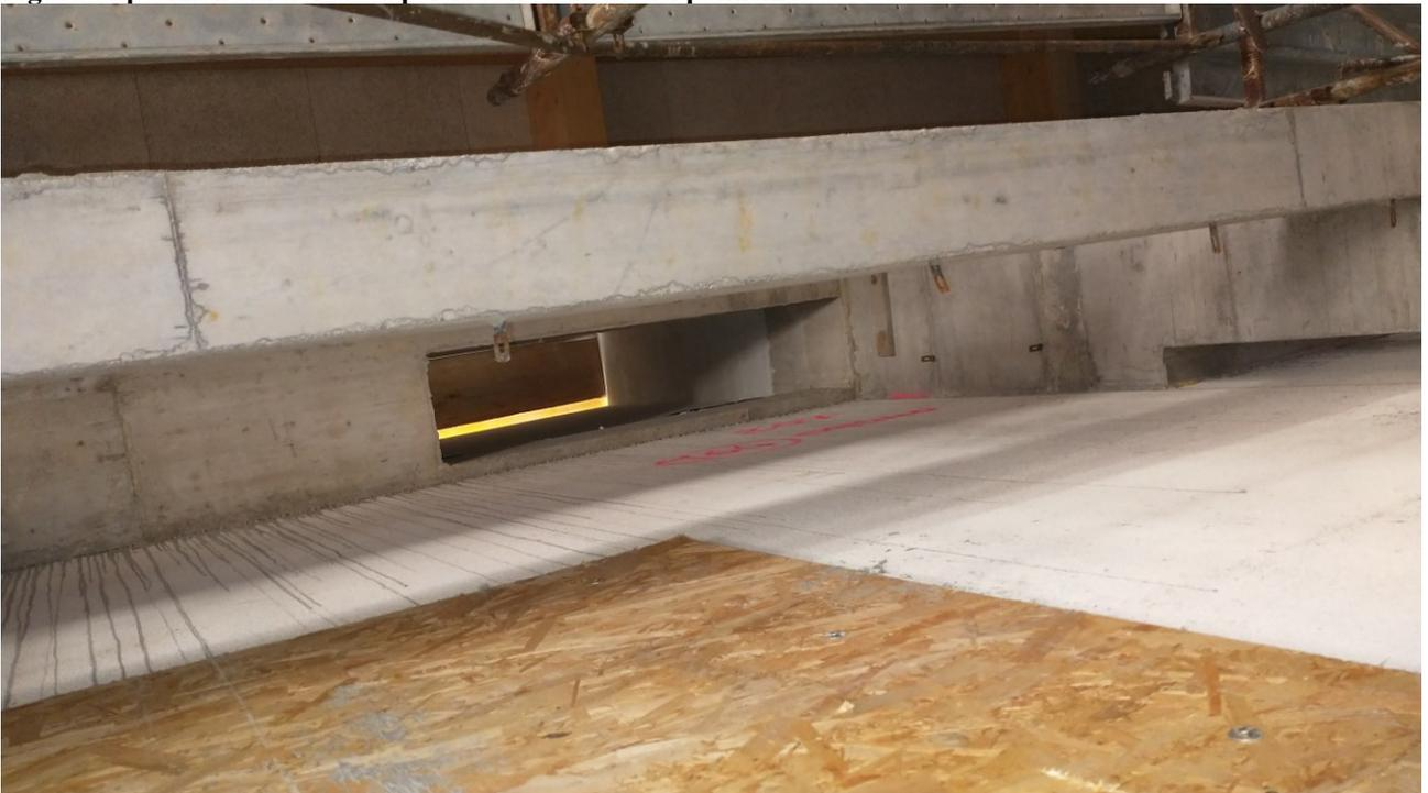
**Figura 8: cavedi predisposti per il raggiungimento del contatore.**
